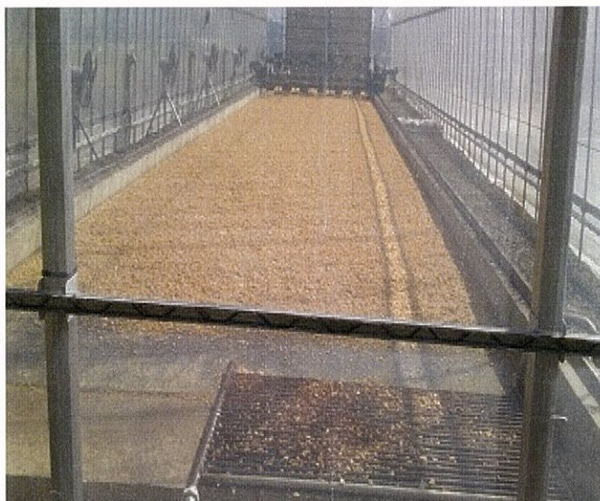
●プレートコイル設置状況
