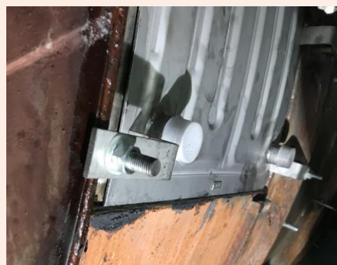
プレートコイル取付
