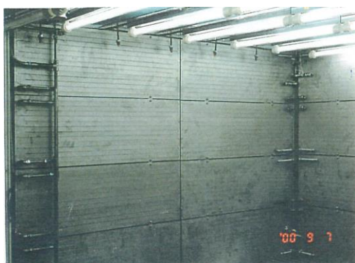
試験室の壁面パネル
