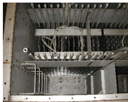
● タンク内プレートコイル設置状況
