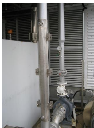
ラージパスタイプ 熱媒・冷媒の流量が多く 圧損も高い場合に最適
