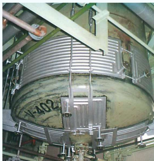
タンクへの設置
