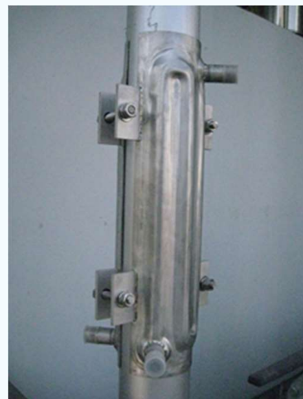
配管への設置
