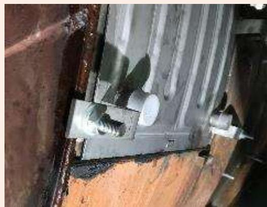
ジャケットの補強部にプレートコイル取付用ボルトを溶接
